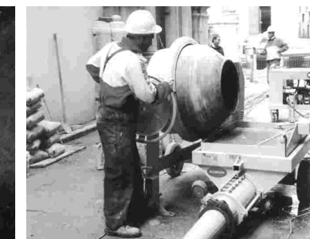
Les dimensions limitées facilitent la mise en place sous les malaxeurs: bétonnières, etc.
