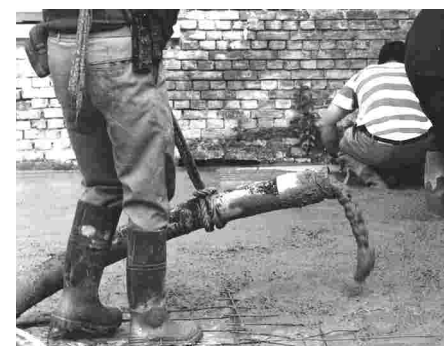
Pompage de béton
